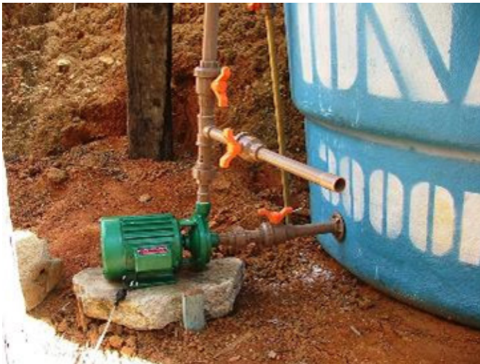
Figura 26. Montagem correta da bomba afogada, com registros, luvas de união e saída para drenagem do reservatório. Fonte: foto dos autores.
