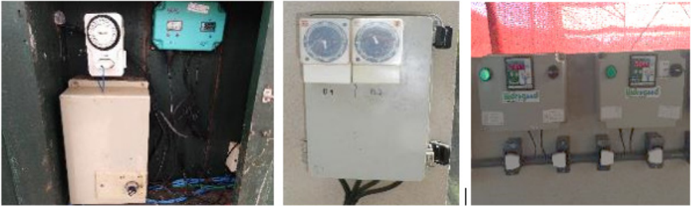
Figura 38. Sistema simples de automação para hidroponia: temporizador analógico e quadro de acionamento da bomba e monitor de pH e condutividade elétrica (esquerda e centro) e temporizador digital (direita). Fonte: fotos dos autores.
