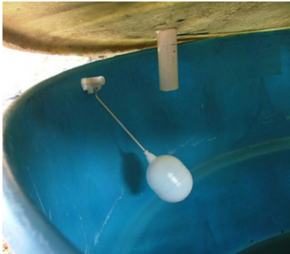
Figura 27. Presença da válvula boia no reservatório de solução nutritiva.
