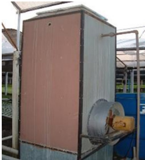
Figura 42. Torre de resfriamento de solução nutritiva. Fonte: foto dos autores.
