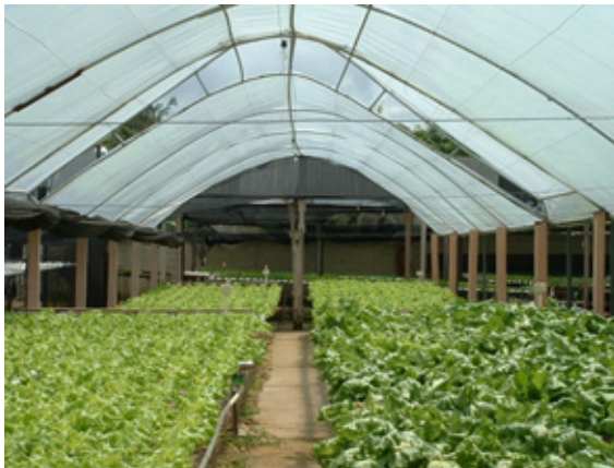
Figura 3. Modelo de estufa popularizado no Brasil. Ver detalhe de saída de ar quente em abertura no telhado. Fonte: fotos dos autores.
