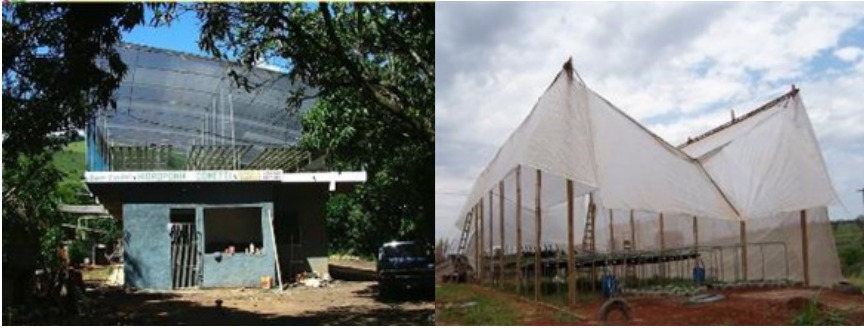
Figura 13. Estufa em uma água sobre uma casa (esquerda), estufa em duas águas com estrutura em bambu (direita) (Fonte: fotos dos autores).
